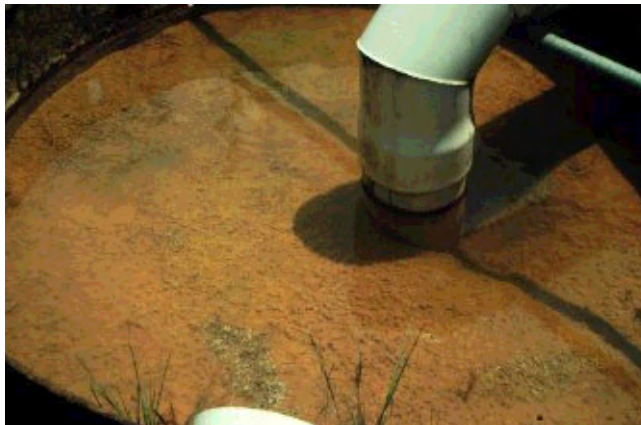
Abb. 26: Carbonat-Umkehr-Brunnen, deutlich zu erkennen der in Suspension befindliche Kalkschlamm aus SKOUSEN (O.J.)
