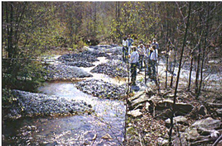
Abb. 22: Geschüttete Carbonatwälle in einem Grubenwasseraustritt Swatara Creek, Pennsylvania aus ANONYM I (O.J.)
