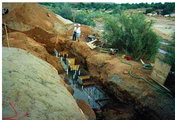
Abb. 47: Reaktivwand mit Monitoringequipment fertig zur Überdeckung mit natürlichem Material aus ANONYM S (O.J.)
