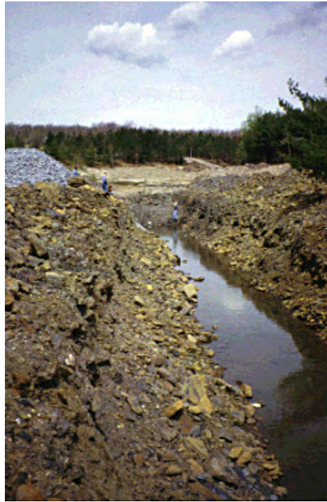
Abb. 29: Anoxic Limestone Drain (ALD) während des Baus; Swatara Creek. (linker Bildhintergrund: der einzubringende Kalkstein) aus ANONYM I (O.J.)
