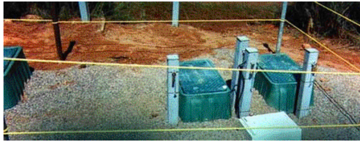
Abb. 48: Reaktivwand mit Monitoringpunkten nach Überdeckung mit natürlichem Material aus ANONYM S (O.J.)
