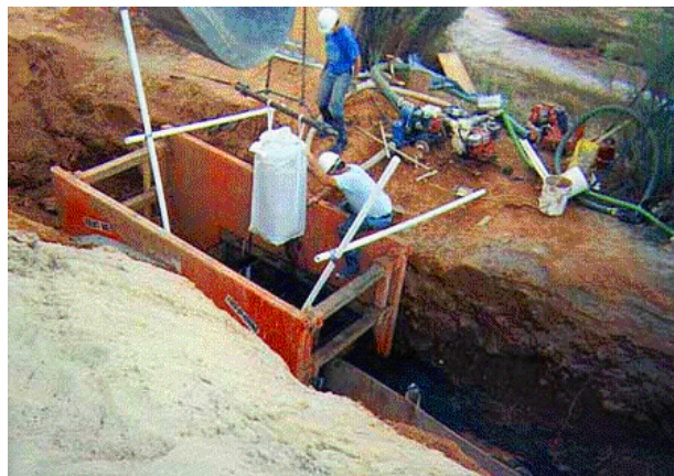
Abb. 46: Reaktivmaterial (Cercona Bone Char Phosphate) wird in den Torbereich der reaktiven Wand eingebracht aus ANONYM S (O.J.)
