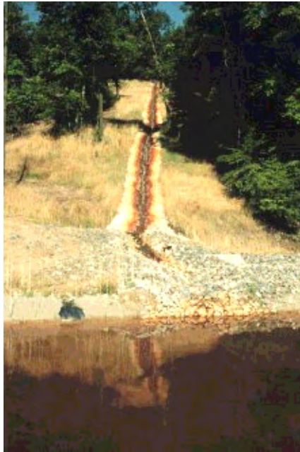
Abb. 21: Carbonatkanal mit nachgeschaltetem Absetzbecken aus SKOUSEN (O.J.)
