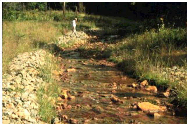
Abb. 20: Länger in Betrieb befindlicher Carbonatkanal mit Eisenhydroxid- ablagerungen aus SKOUSEN (O.J.)
