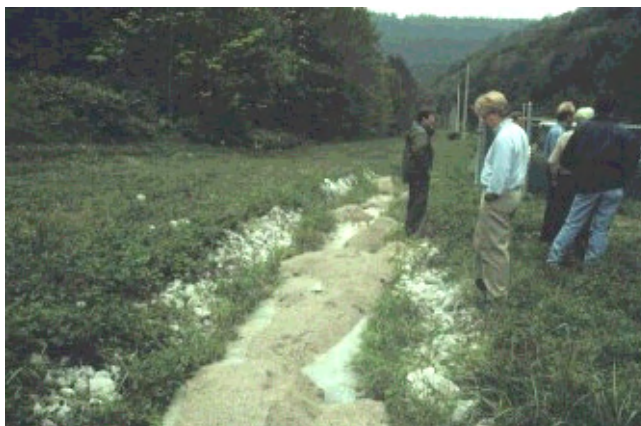
Abb. 27: Carbonatsand, direkt in ein Fließgewässer eingebracht aus SKOUSEN (O.J.)
