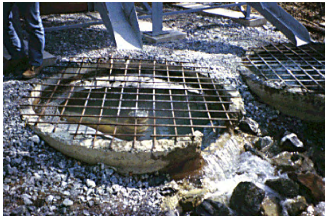
Abb. 25: Carbonat-Umkehr-Brunnen; Swatara Creek aus ANONYM I (O.J.)
