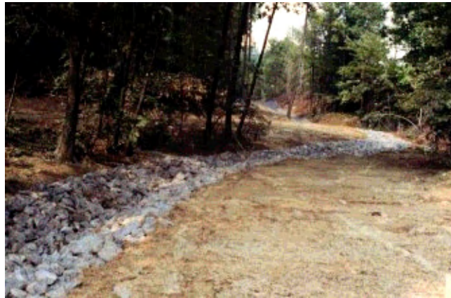
Abb. 19: Vorbereiteter Carbonatkanal vor der Grubenwassereinleitung aus SKOUSEN (O.J.)
