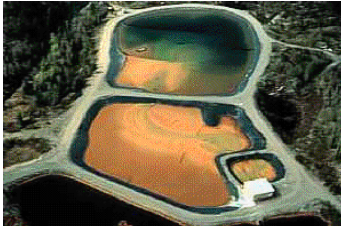
Abb 65: Schlammabsetzbecken bei aktiver Reinigung, Versuchsanlagen zur Reduzierung von Metallmobilitäten, Volumennahme und Deponierungskosten aus ANONYM Q (O.J.)
