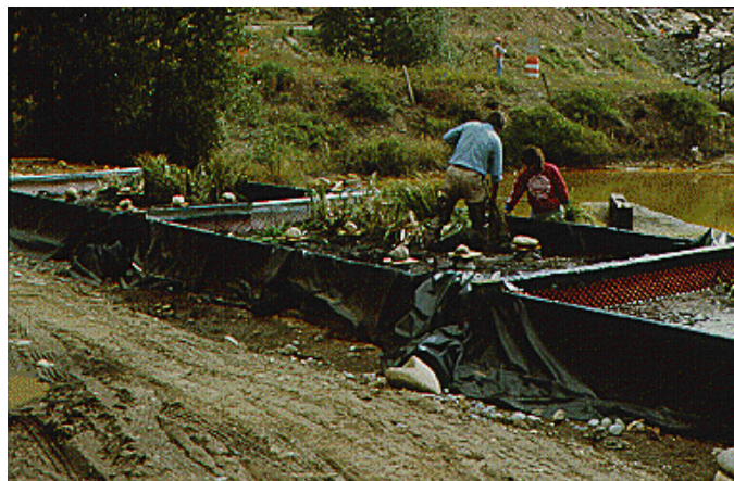
Abb. 36: aerobes Wetland in rein technischer Gestaltung aus ANONYM M (O.J.)
